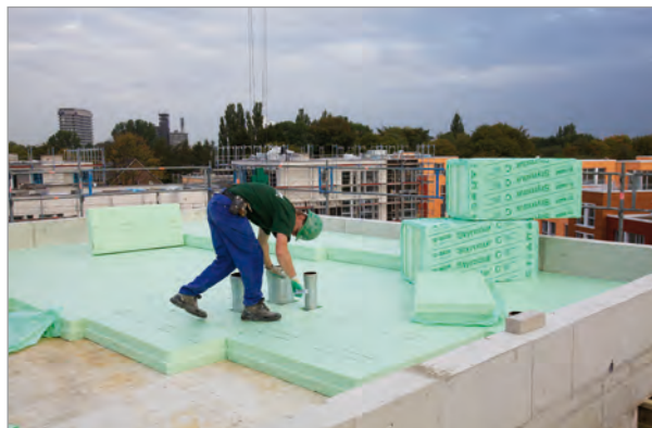
Bild 1: Zweilagige Verlegung von Styrodur® C - bessere Dämmung und leichtere Verarbeitung
