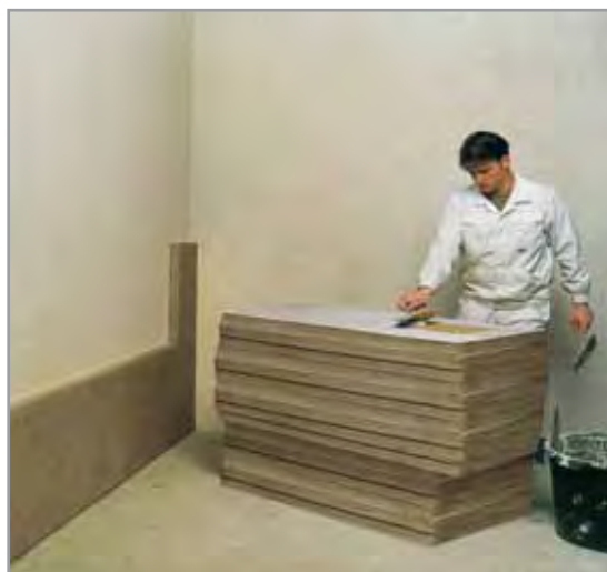
Bild 1: Alte Innendämmung mit ISOVER
