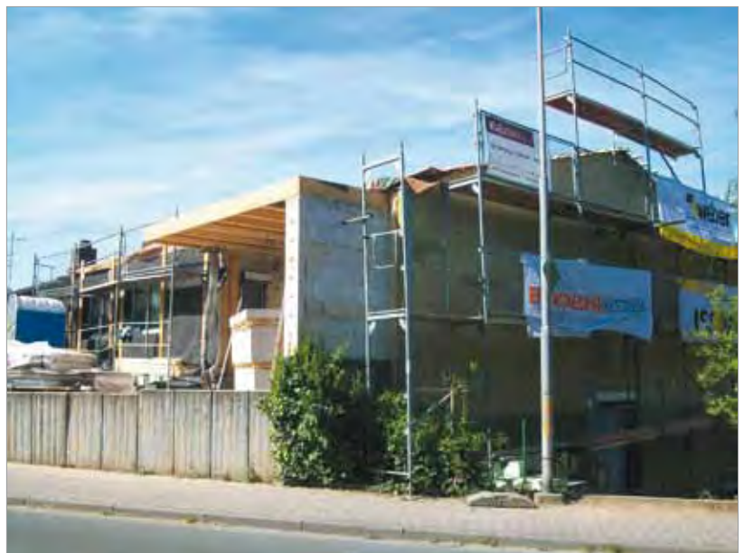
Bild 1: Foto des Gebäudes während der Baumaßnahme
